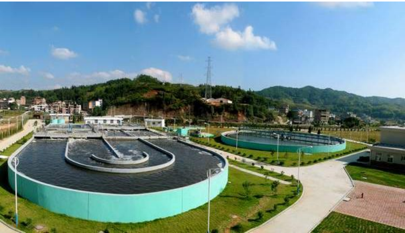
德化县污水处理厂
