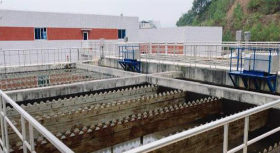
坪埔水厂现状图
